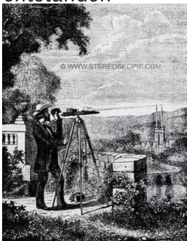
Abbildung 2 Die Kamera wird zur Aufnahme seitlich verschoben. (1862)
